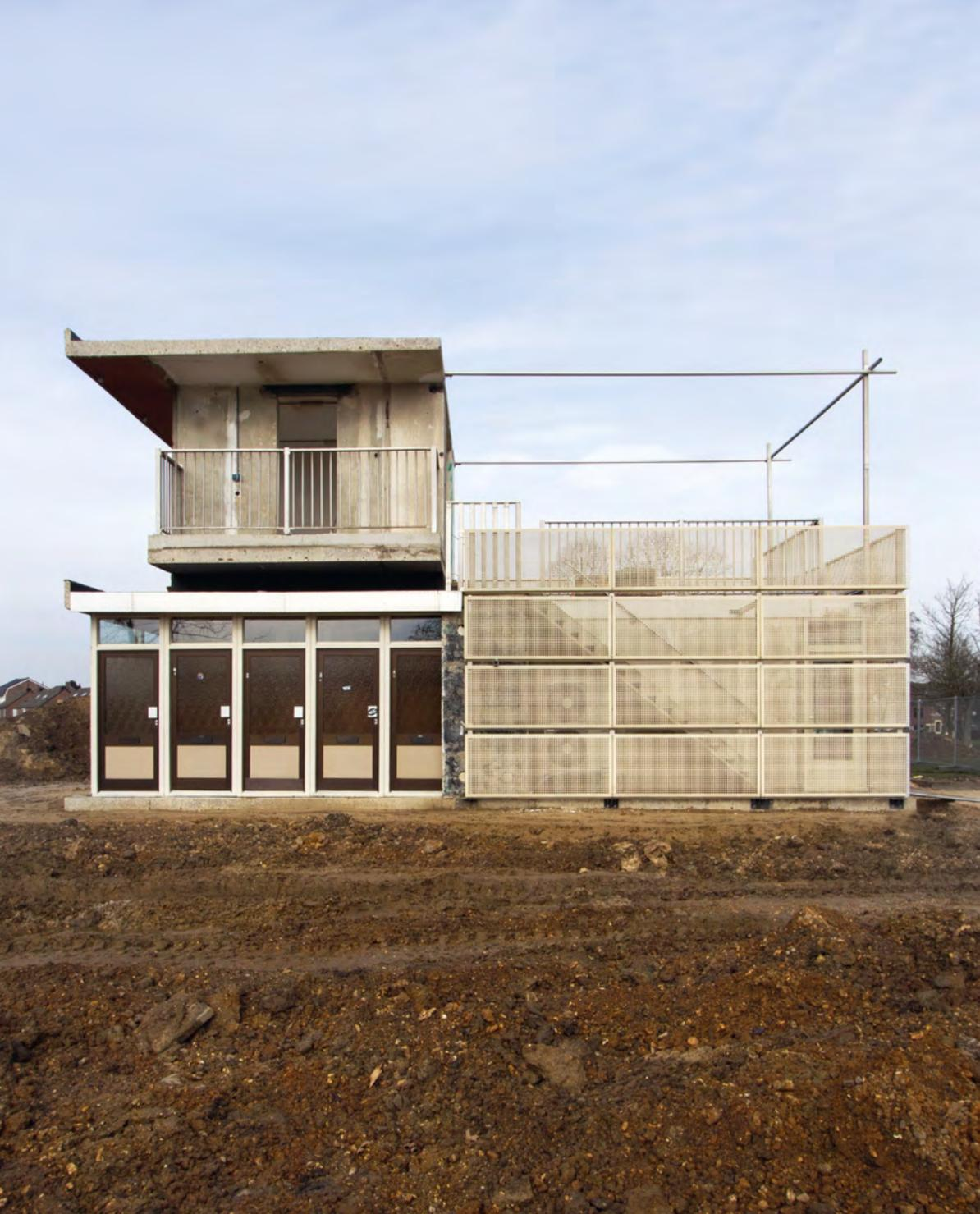
Der Prototyp aus wiederverwendeten Baumaterialien.
