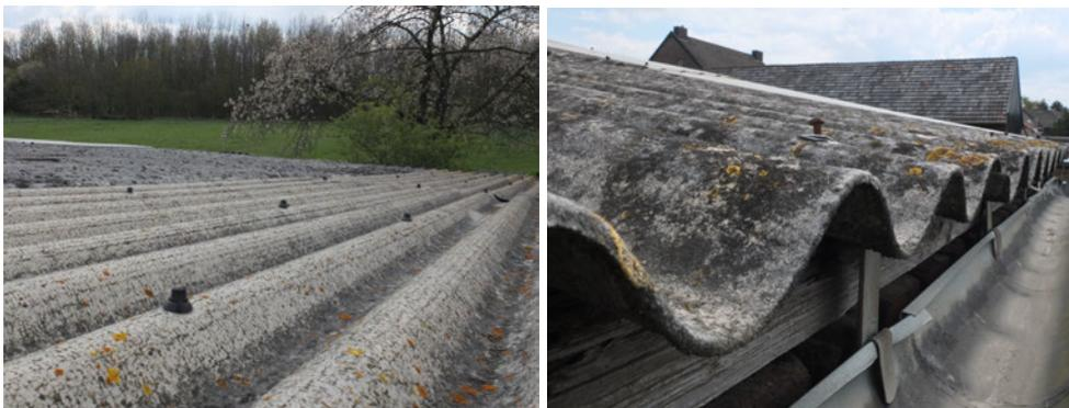
Bei diesem Projekt sind sowohl der Kuhstall, der Rinderstall, der Geräteschuppen, sowie auch ein Teil der Scheune mit einer Dachdeckung aus Wellplatten gedeckt. Das macht eine Gesamtmenge von rund 700 m<sup>2</sup>. Da die Wellplatten nachgewiesenermaßen asbesthaltig (Eternit) sind, ist eine Wiederverwendung dieser ausgeschlossen und sie müssen fachgerecht als gefährlicher Abfall entsorgt werden.
