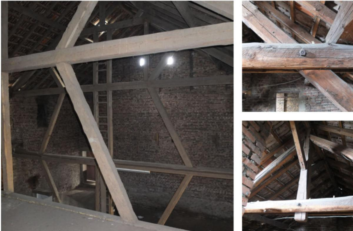
Alle der hier befindlichen Gebäude haben Dachkonstruktionen aus Holz, die jeweils in den Abmessungen variieren, weniger aber im Zustand. Außerdem gibt es Holztramdecken in beiden Wohnhäusern. Ersten Einschätzungen nach eignen sich alle gut erhaltenen Holzbalken für eine Wiederverwendung, solange sie sorgfältig zurückgebaut und gegebenenfalls auf Schadstoffe geprüft werden.
